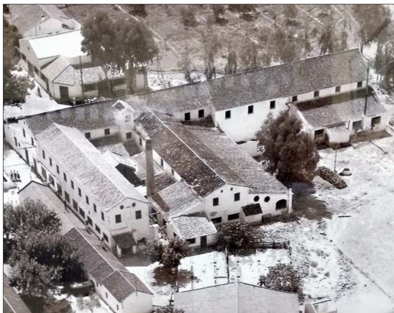
Muestra de cómo eran en su inicio las instalaciones de Faccsa-Prolongo en Cártama (Málaga).
