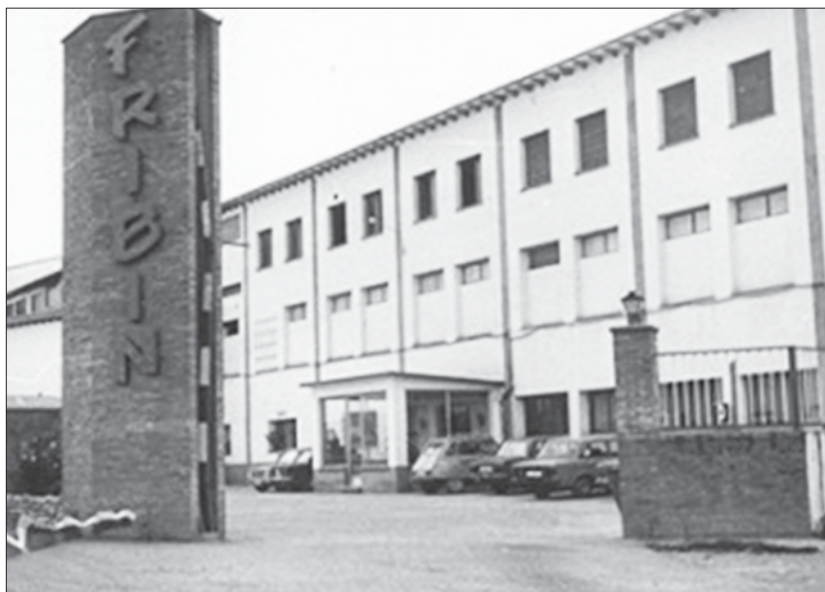
Antigua entrada al matadero de Fribin en Binéfar (Huesca).
